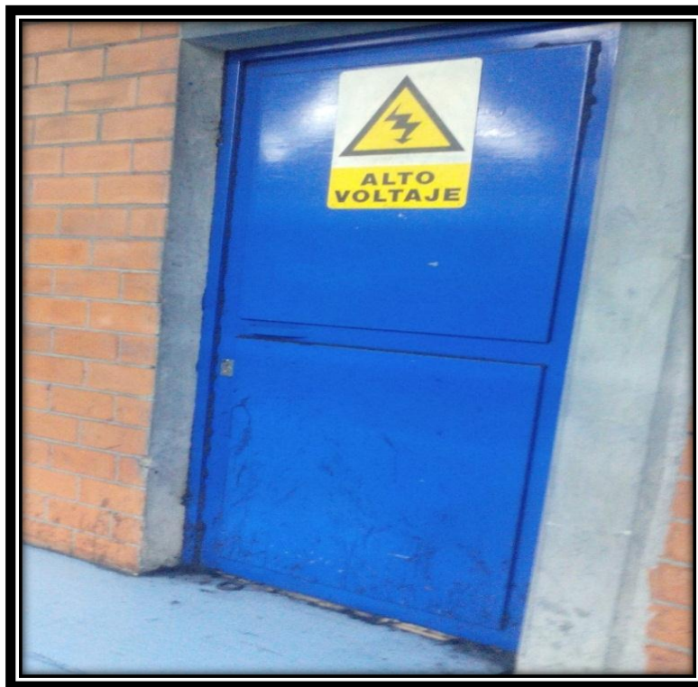
Fotografía 3. Entrada principal a la subestación
